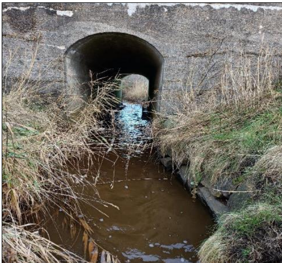
Figur 15: Udløbet under jernbanen. Der er stensikret langs begge brinker.
