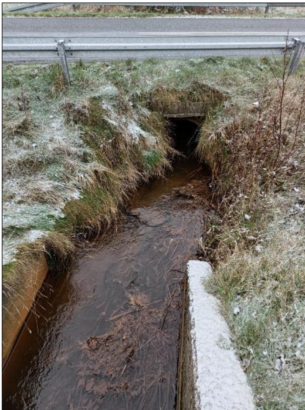
Figur 7: Udløbet under Novrupvej ved st. 2.847 m fremgår øverst i billedet, og indløbet under Tjæreborgstien fremgår nederst i billedet.
